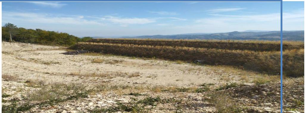
*Vallo dissipatore realizzato attraverso scavo e costruzione di muratura in terra armata (Terramesh)*
