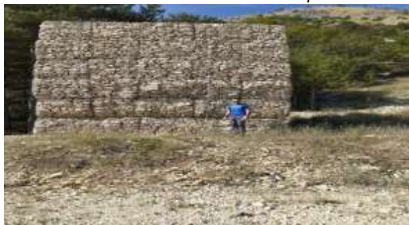
Muratura a valle del vallo dissipatore
