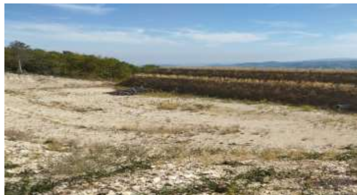
Vallo dissipatore realizzato attraverso scavo e costruzione di muratura in terra armata (Terramesh)
