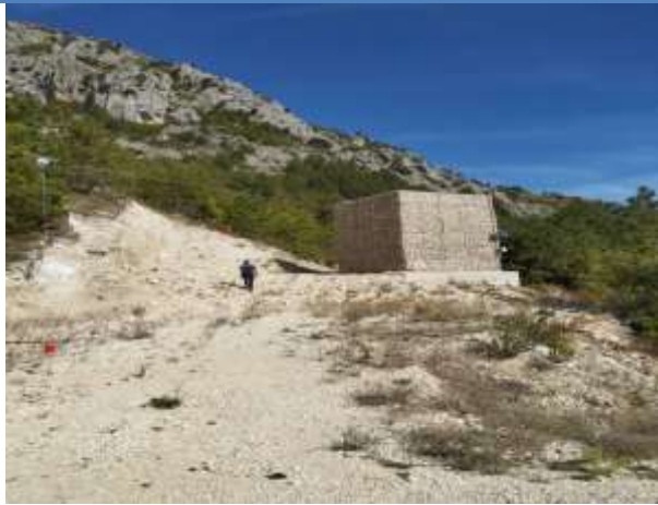
Speroni deviatori realizzati in cemento armato e rivestiti in pietra
